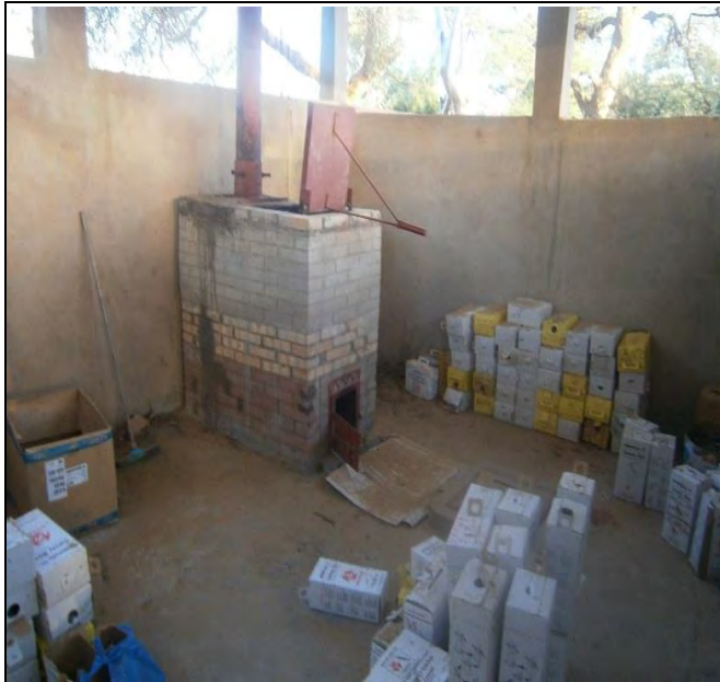
Photo n°5 : stockage final des BS dans l'enceinte de l'incinérateur
