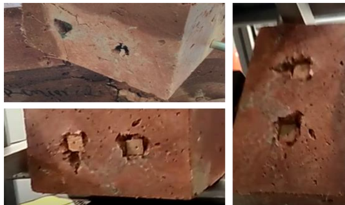
Figure IV.21: Glissement des armatures
