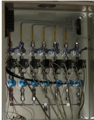
**Figure 53 : Armoire de distribution des gaz**
