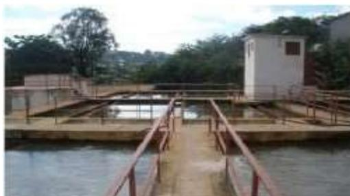
**Photo 3 : Décanteur Pulsator II**
