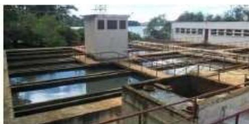
**Photo 2 : Décanteur Pulsator I**
