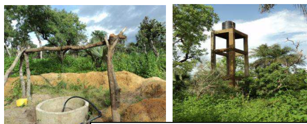
Forage villageois de kabadio
