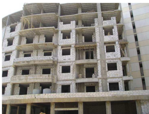
Figure 1.36: mode de construction au Liban (Mourtada, 2010).
