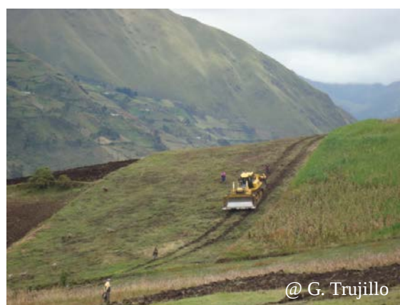
Figure 24. La cangahua , dépôt de cendre indurée en surface et réhabilitation de celle-ci au moyen de bulldozer.
