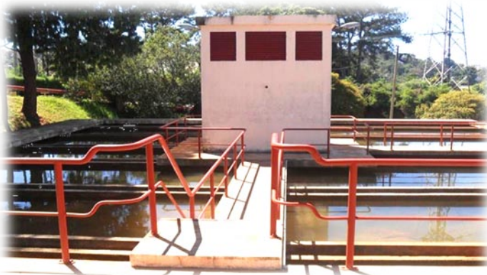
Figure 4 : Décanteur Pulsator
