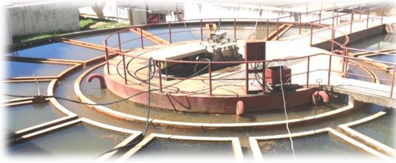
Figure 3 : Décanteur Accelator
