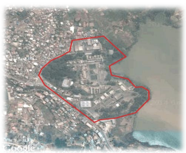
Figure 2: Usine de traitement d'eau potable de la JIRAMA Mandroseza [Google earth]
