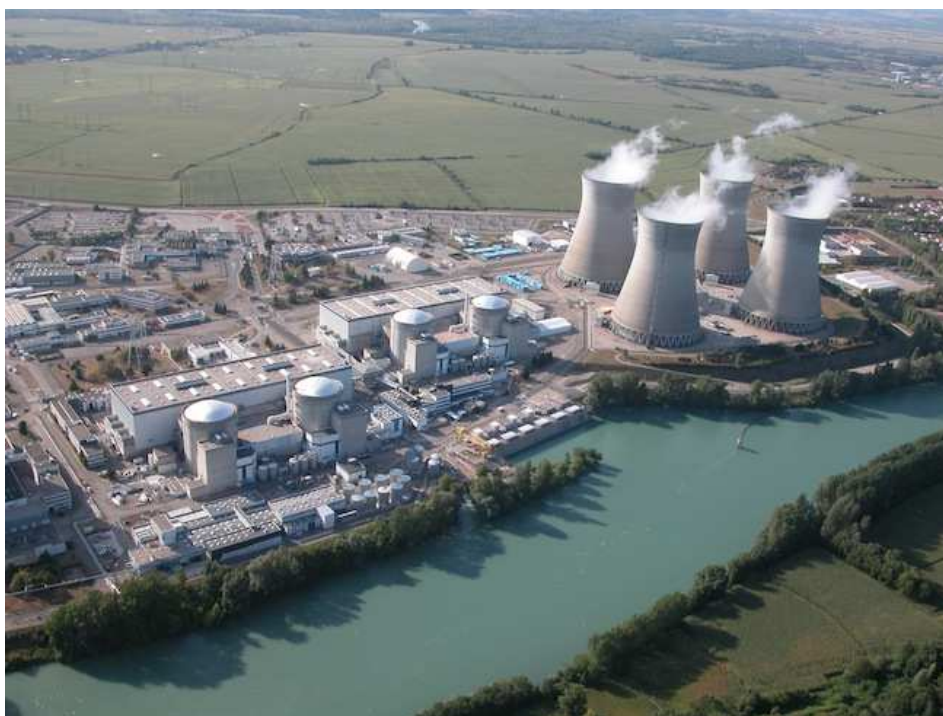
Fig. 5 – Vue aérienne du CNPE Du Bugey
