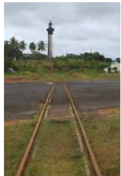
Figure 16: Aéroport de Manakara
