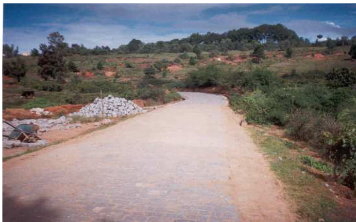
Photo 5 : Réhabilitation de l'ancienne route principale
