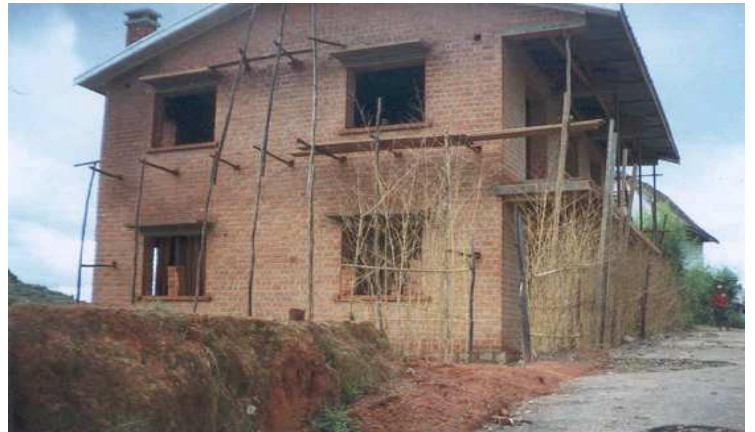
Photo 2 : Type de maison en voie de construction
