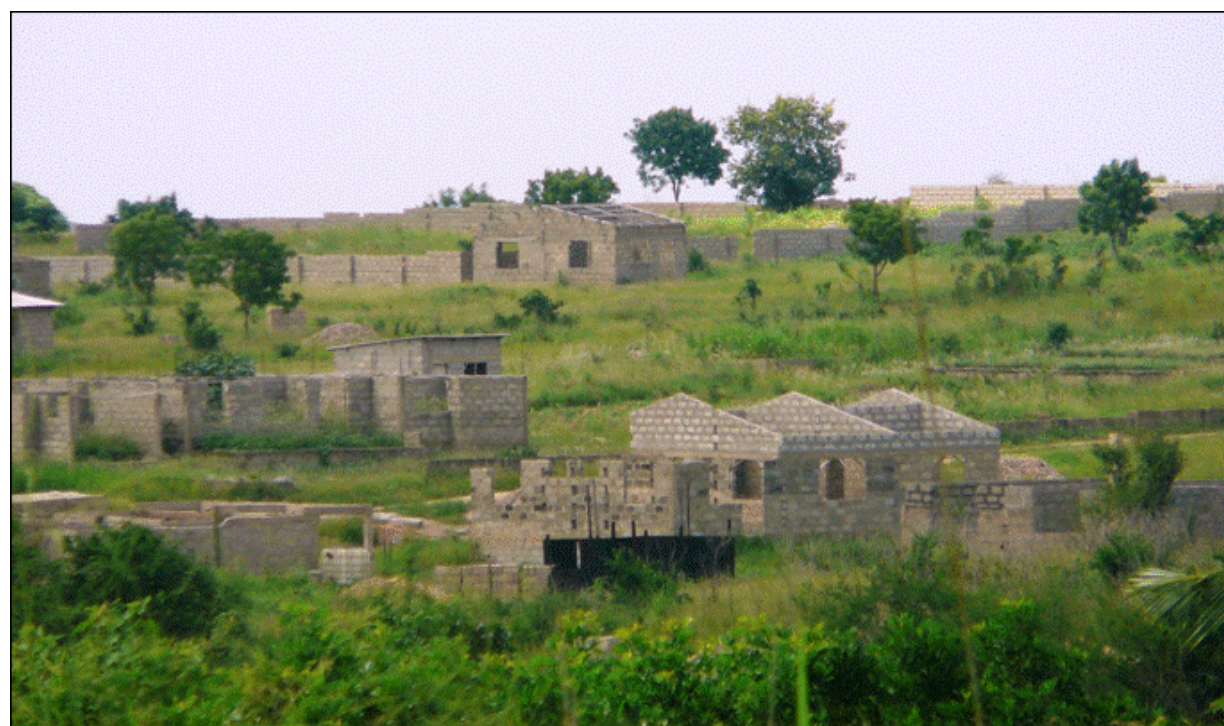
Photo 3: La zone tampon d'Accra en construction
