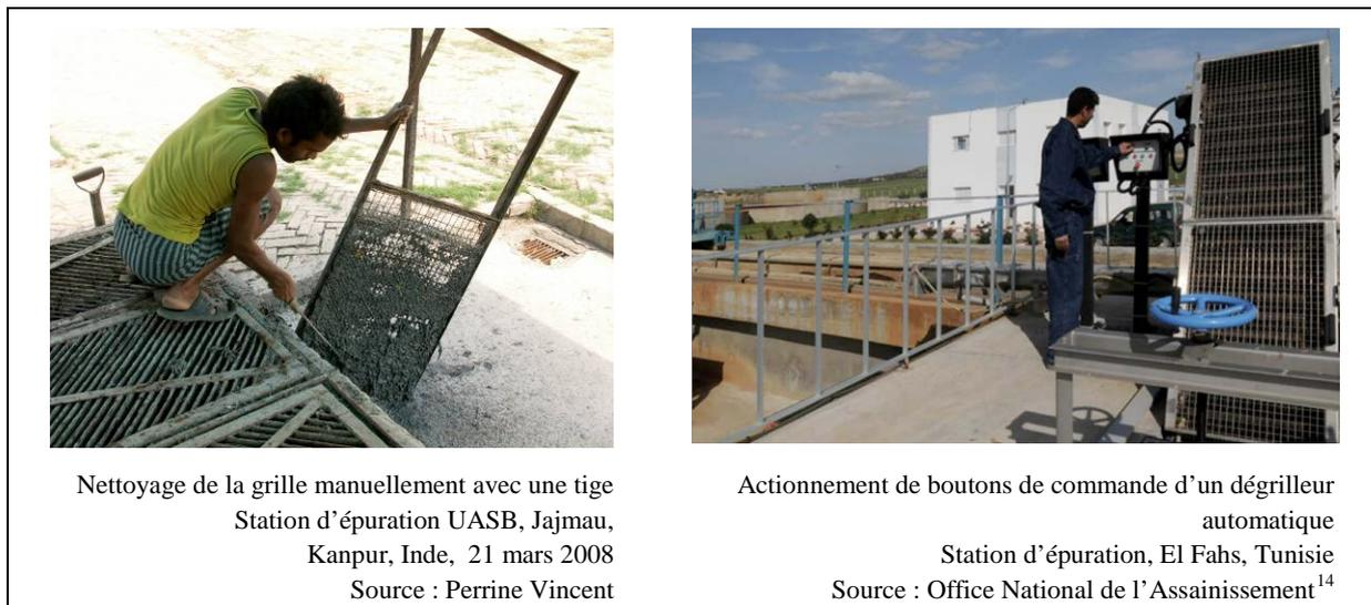
Nettoyage de la grille manuellement avec une tige
