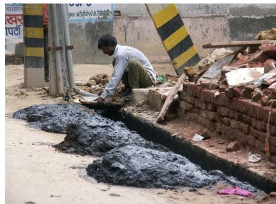
Nettoyage d'une rigole d'assainissement
