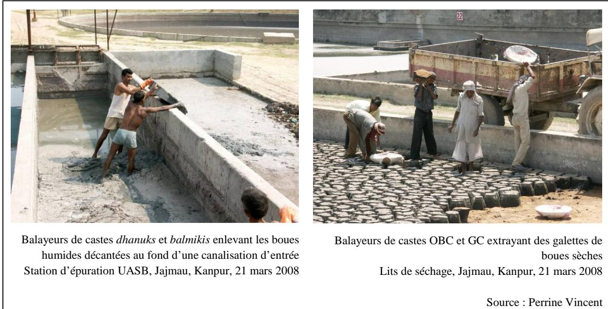
**Photographie 21 – contacts des employés avec les eaux usées et les boues séchées**
