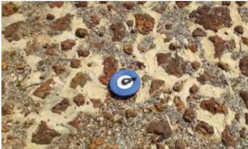
Figure 6.16: Enrochement en latérite de la digue
