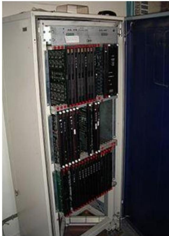
**Figure 1.0 4 :** Autocommutateur de forte capacité.
