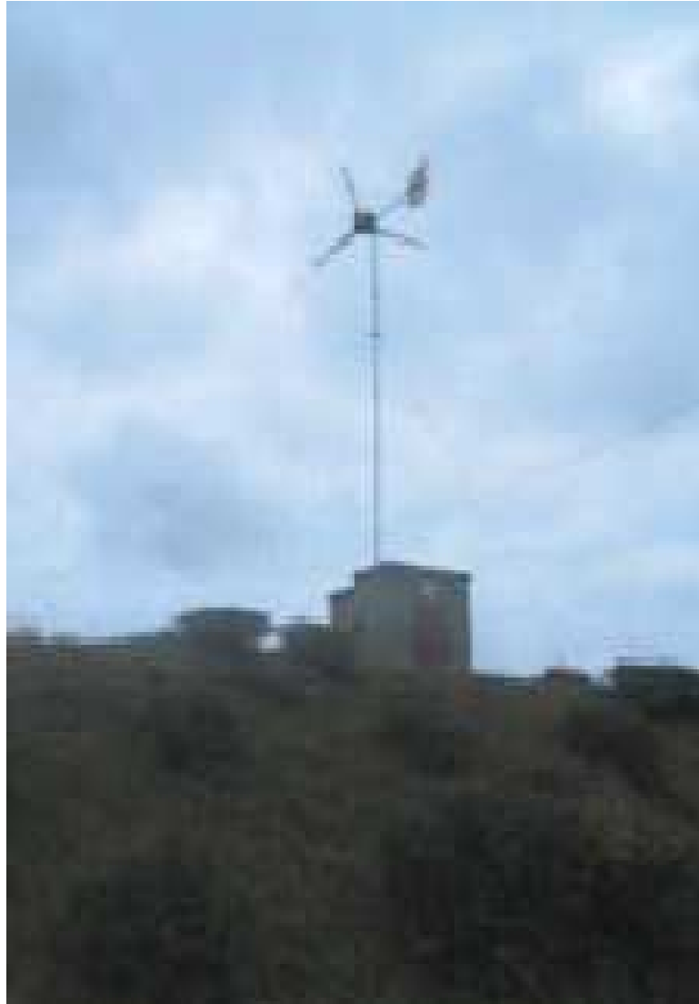
Figure 2-4 : Eolien à axe horizontal à alternateur discoïde
