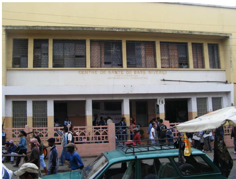
Figure 5 : Le CSB2 d'Isotry central : vue de face.
