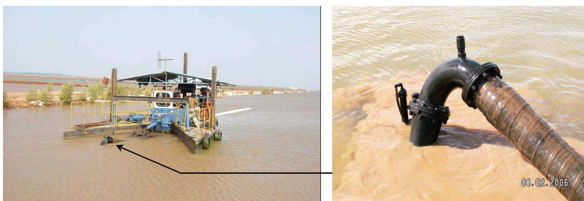
Figure 7 : dragage dans le canal d'alimentation
