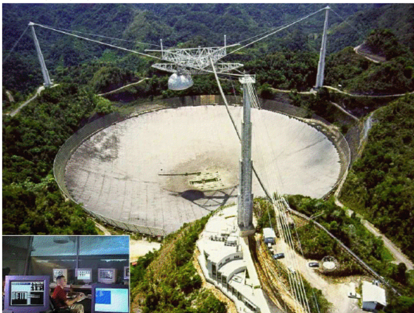
Parabole fixe avec foyer mobile Exemples ARECIBO D=300\text{ m}
