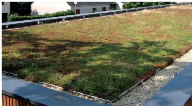
*Figure I.3 : Photo d'une toiture verte extensive [28]*
