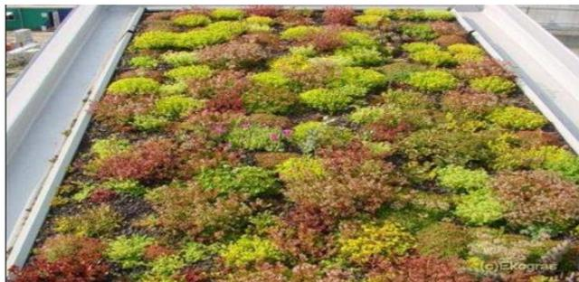
**Figure I.4 :** Photo d'une toiture verte semi-intensive [28]
