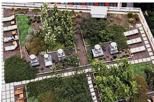
**Figure I.5 :** Photo d'une toiture verte intensive [28]
