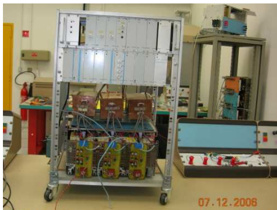
Le rack vue de face
