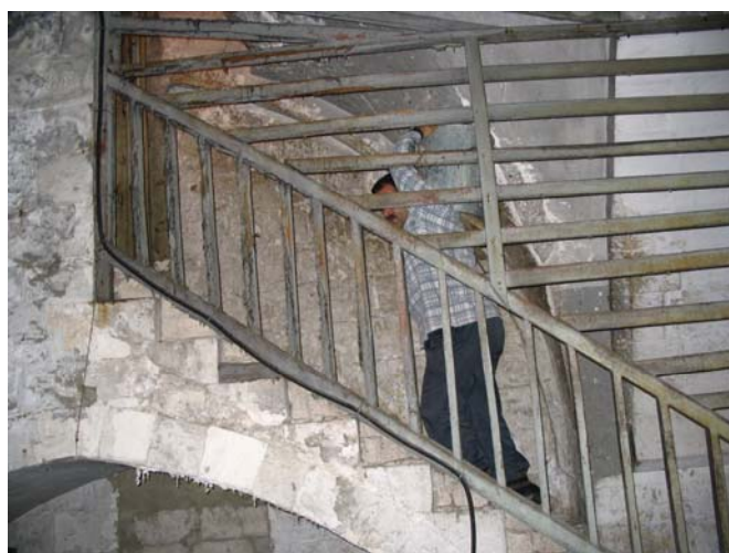
Photo 40. Les ouvriers du bast montent à l'étage...
