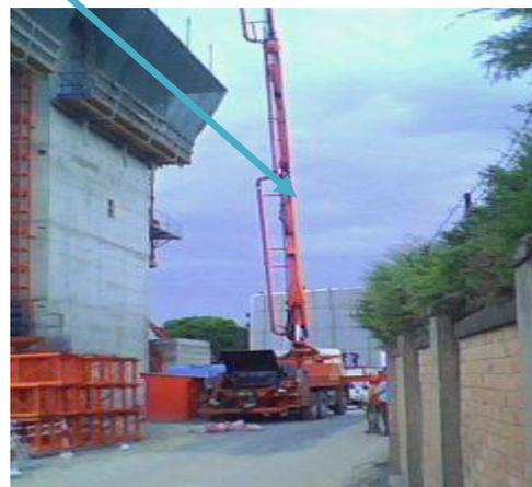
**Figure 16:** Pompage du béton
