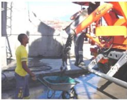
**Figure 2:** Echantillonnage du béton frais
