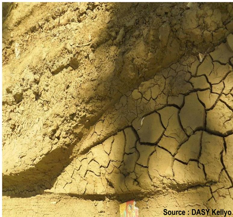
**Photo 10** : Zoom sur la dégradation avec structure argileuse –
