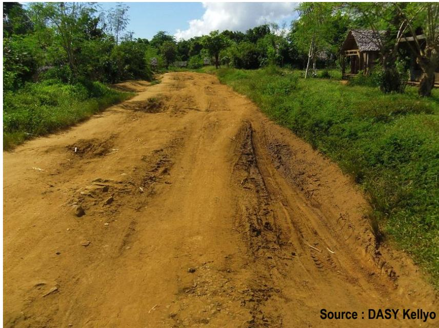
**Photo 9** : Dégradation du tronçon - Ambodipont
