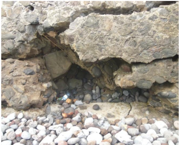
Photo 13: Digue déstabilisée
