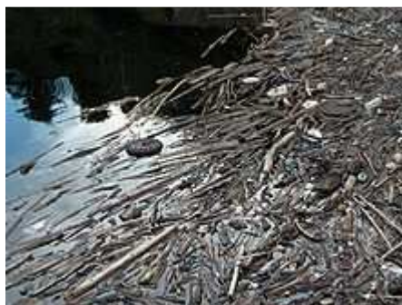
Figure.48.-Entretien des barrages.
