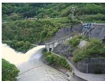
Figure.43. -Évacuateur de crues du barrage Matsumoto (Préfecture de Nagano, Japon)
