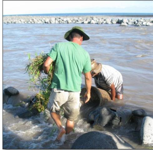
Photo 5. Utilisation de végétaux pour faire l'étanchéité entre la vouve et les galets, rivière du Mât, 2015, ©Becheler
