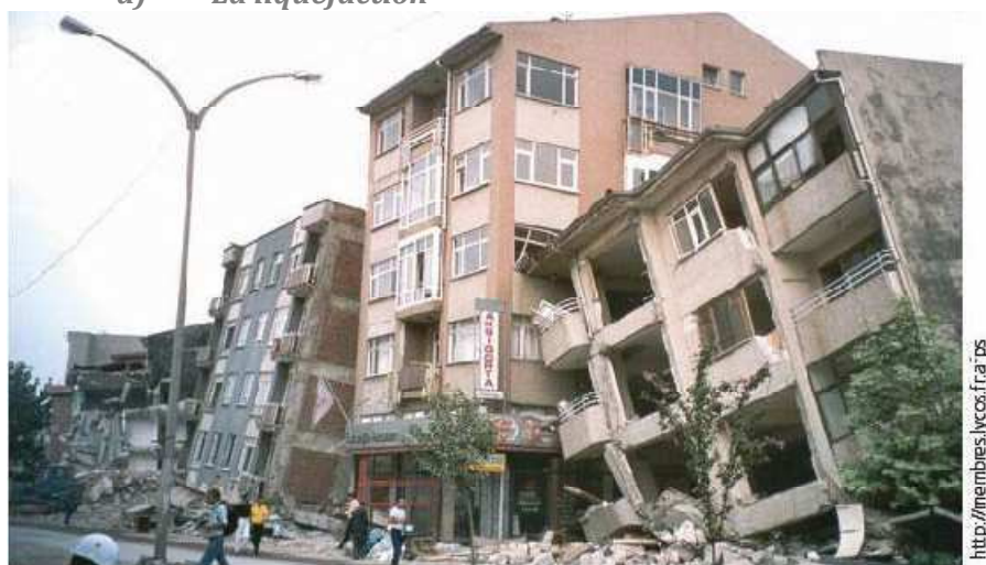
Illustration 9 : Exemple du phénomène de liquéfaction à IZMIT en 1999
