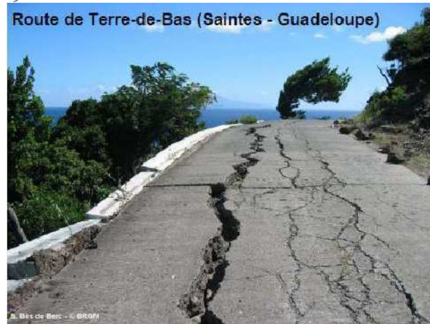
Illustration 11 : Exemple de dégâts causés par un mouvement de terrain aux Saintes en 2005 Source : BRGM
