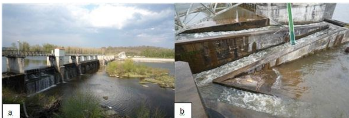
Figure 9 : Vue du barrage de Mauzac (a) et de sa passe à ralentisseur (b) (Source : EPIDOR)
