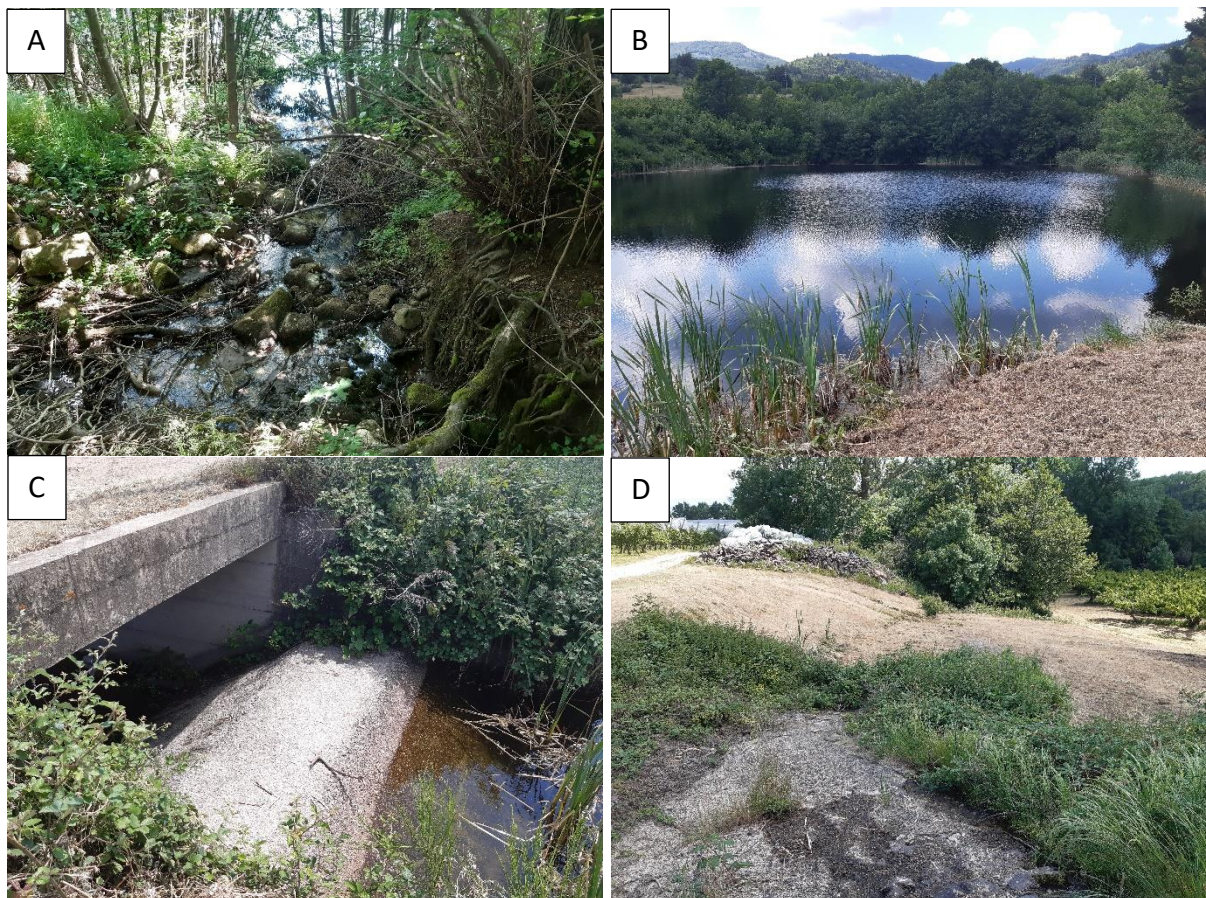
A : cours d'eau à l'amont de la retenue ; B : Retenue d'eau ; C : Ouvrage de restitution = surverse ; D : Cours d'eau à l'aval immédiat de la retenue
