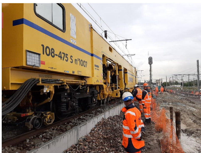
Figure 7 : Train-travaux de type "bourreuse" en action sur le chantier de 2QP - Matéo Segrada
