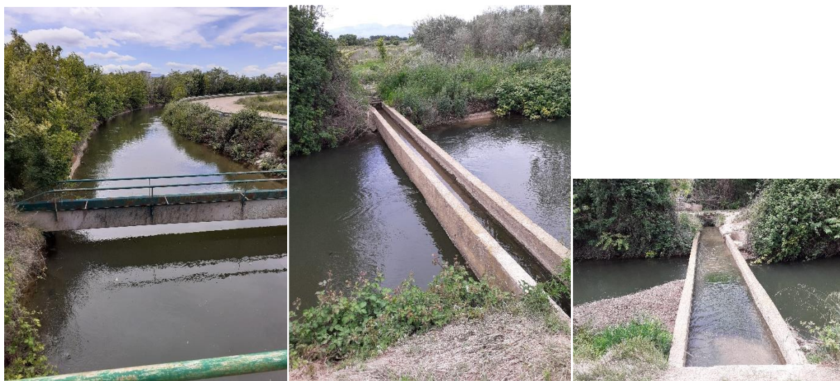
Figure 26: Canaux d'irrigation passant au-dessus du canal de Lodosa à proximité de la rivière Queiles
