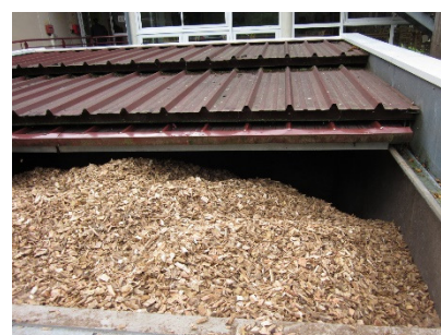
Figure 8 : Silo de stockage des plaquettes au CPA Lathus Source : photo Mathilde ALLERY
