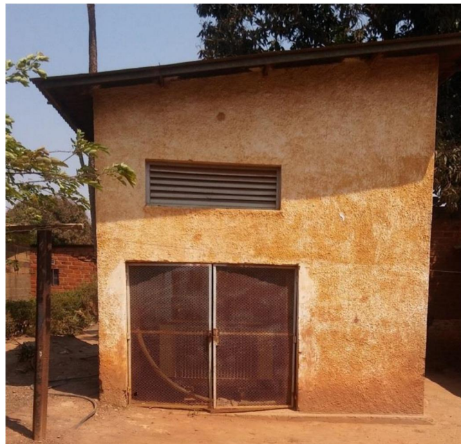
Figure 30: Cabine électrique LAMORAL construite en maçonnerie. (SNEL)
