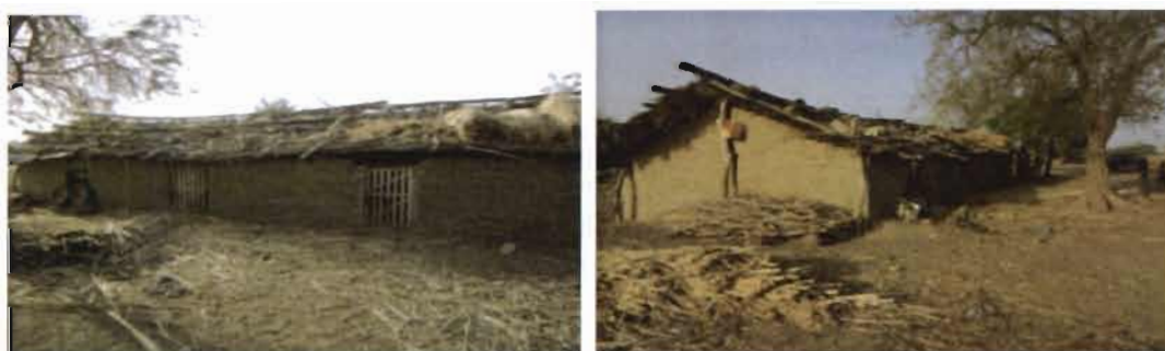
Photo 2 : Silos traditionnels de conservation en banco avec toiture paille (Commune de Gonponsom, Passoré)
