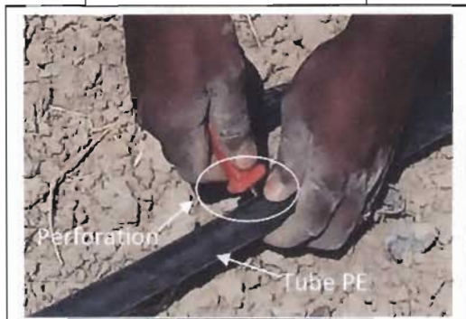
Perforation de tubes PE
