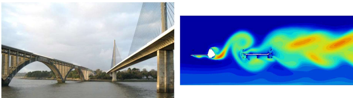
Figure 9. L'influence d'une structure voisine (© Bouygues TPRF / Optiflow)
