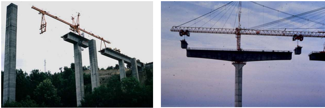
Figure 56. Quelques ponts construits par encorbellements successifs
