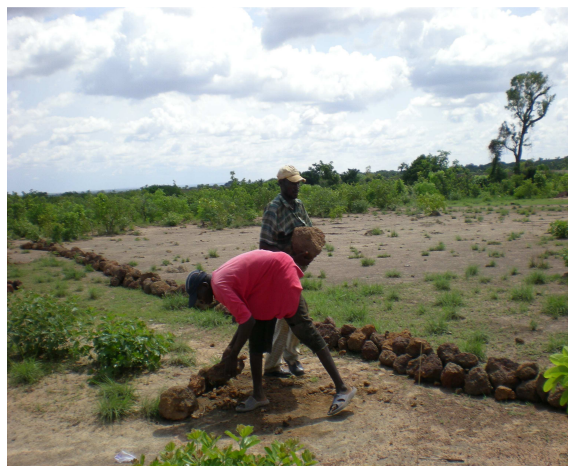
Construction de cordon pierreux
