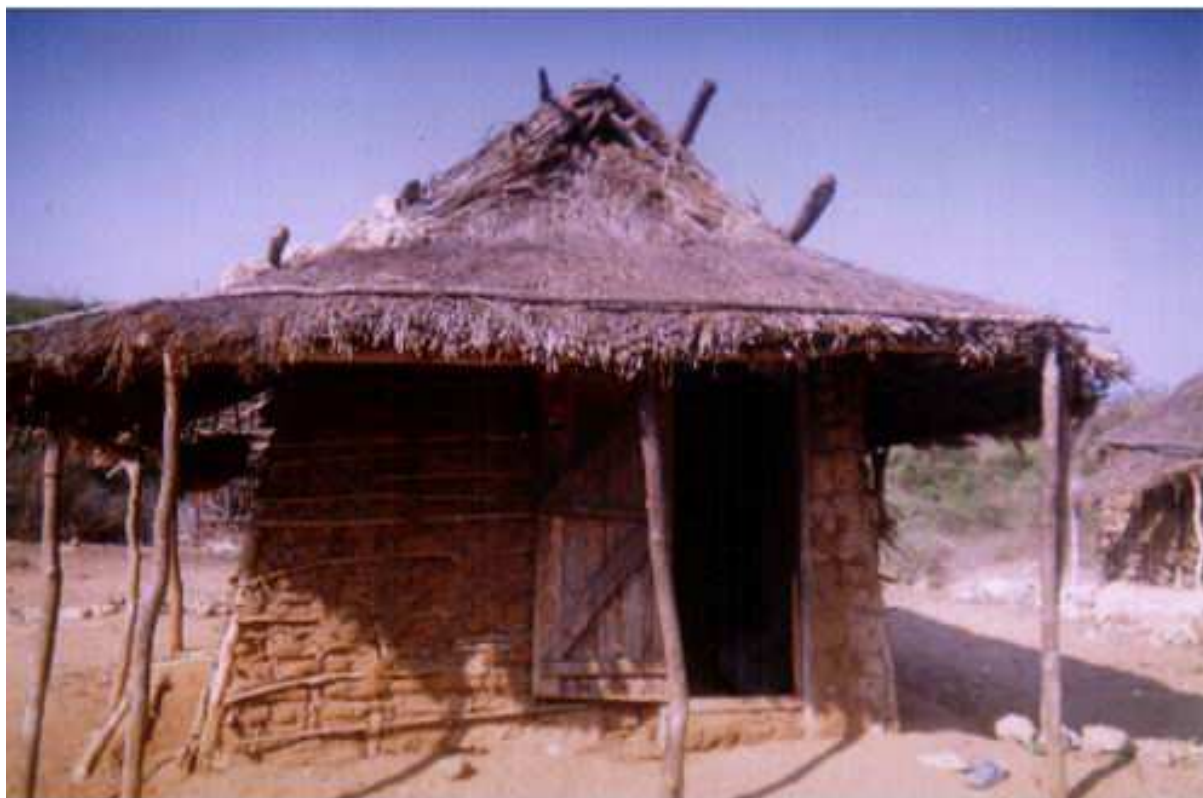
Photo n°15 : Une case de type traditionnel. Tous les matériaux utilisés pour la construction de cette case sont de type traditionnel comme la terre battue, pour les murs et du chaume pour la toiture (Cliché de l'auteur)
