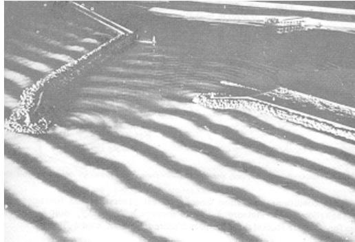
**Figure II.5** – Diffraction par deux brise-lames. *Source* : <http://hmf.enseeiht.fr>, mai 2014
