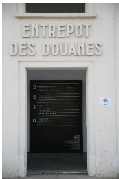
Le bâtiment des douanes, datant du milieu du 19ème siècle et réhabilité, accueille des entreprises assez représentatives des activités présentes sur le site : design, médias, conseil, management et communication. Il abrite également en rez-de-chaussée deux galeries d'art. Photo L. Morand
