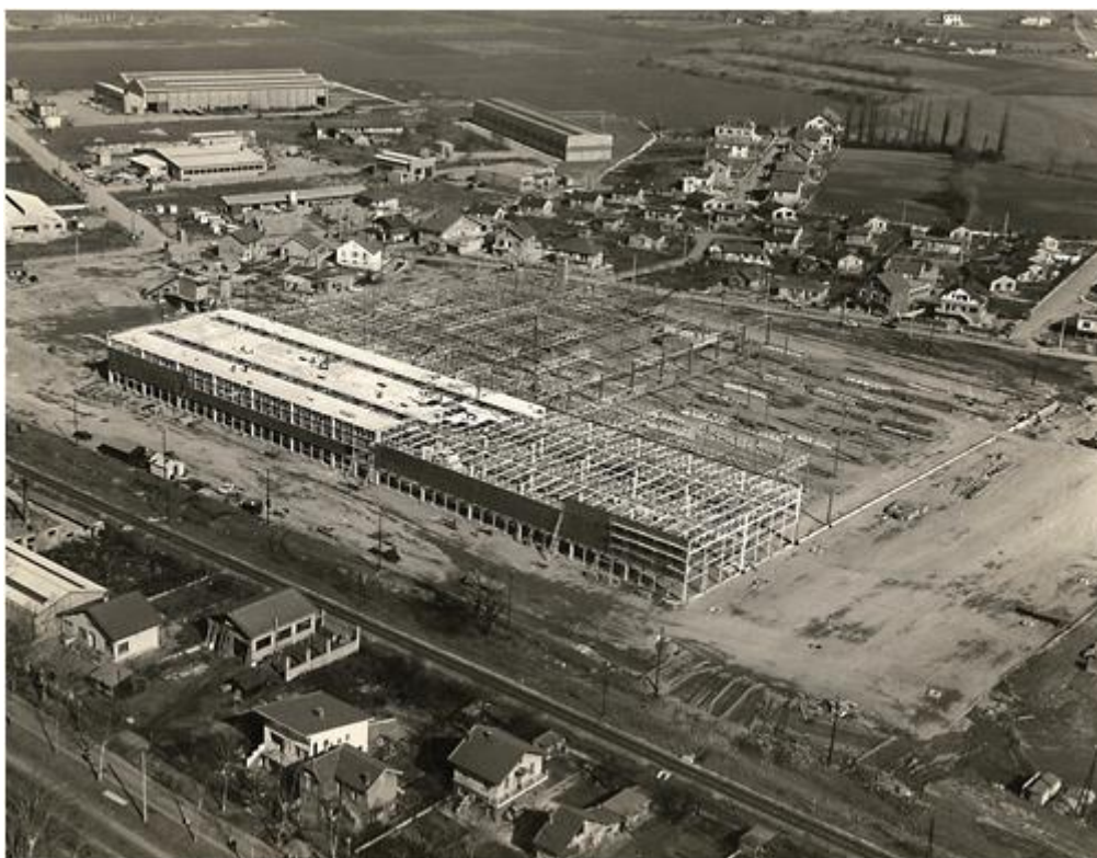
Construction de l'usine Caterpillar, 1963. Collection AME
