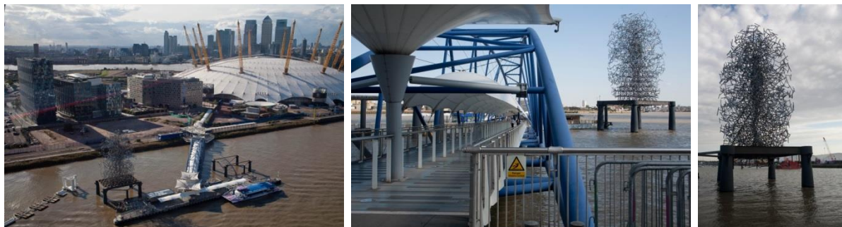
La plateforme d'embarcation pour les navettes fluviales à proximité du Dôme. Sur une ancienne structure industrielle, une œuvre d'art contemporain est installée (« Quantum Cloud » de Antony Gormley). Selon la perspective, elle crée la surprise en dévoilant la forme d'un personnage. Photos L. Morand
