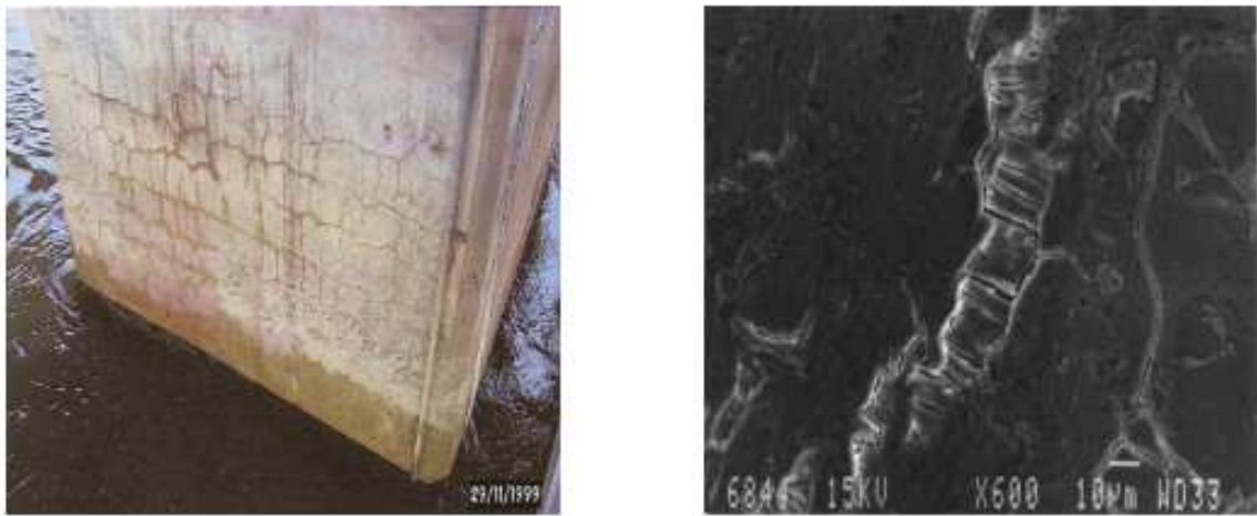
FIGURE 1.2 – Exemple d'une dégradation du béton (RSI) [2]
