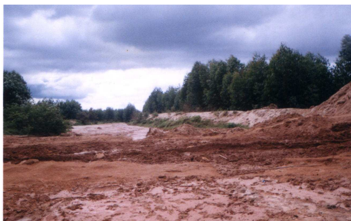
Figure n°11 : Ensablement de canal à Mandrota PK 84+ 000
