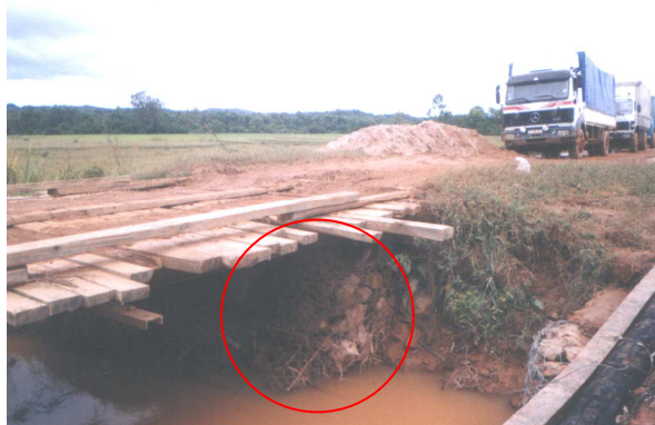
Figure n°9 : Dégradation de la superstructure et les appuis en gabion
