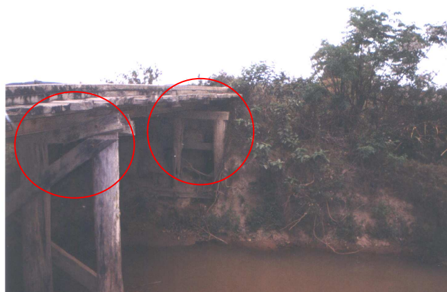
Figure n°10: Dégradation de l'infrastructure du pont en bois au
