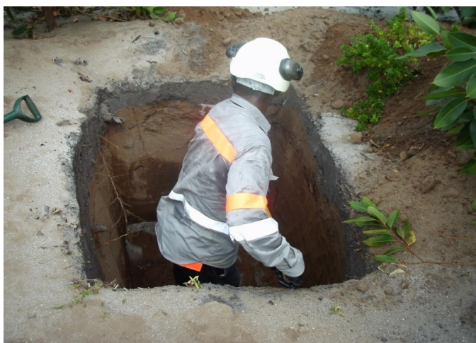
Photo 5: Mise en place d'une fosse pédologique
