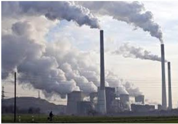
c) Centre électrique fonctionnant au charbon.
