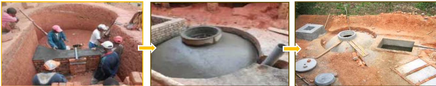
Construction du digesteur
