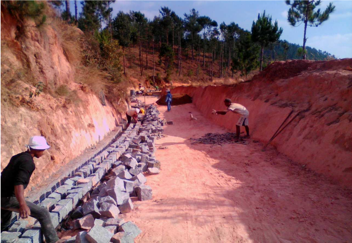
Photo N°02 : Construction d'une route en pavés au Nord dans le fokontany Ambohimanarivo, initiée par la Commune Urbaine d'Imerintsiatosika et la CCPREAS (cliché de l'auteur), Octobre 2017.
