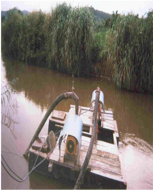
Photo 1 : Pompage sur radeau ( Système d'AEP dans La Commune Urbaine d' Antalaha )
