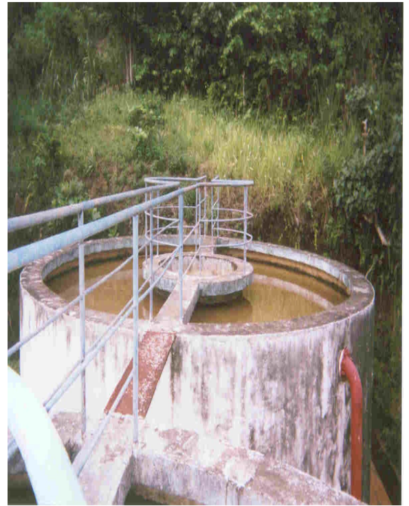
Photo 2 : Décanteurs circulaires (Système d'AEP dans la commune urbaine d' Antalaha )
