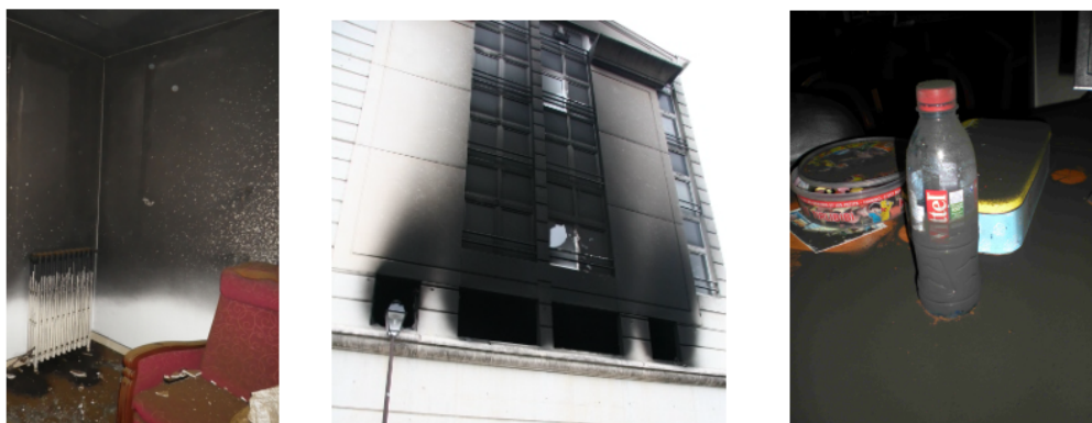
FIGURE 1 – Dépôt de particules de suie lors d'un incendie
