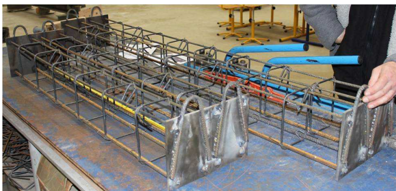
(a) Réalisation du ferrailage
